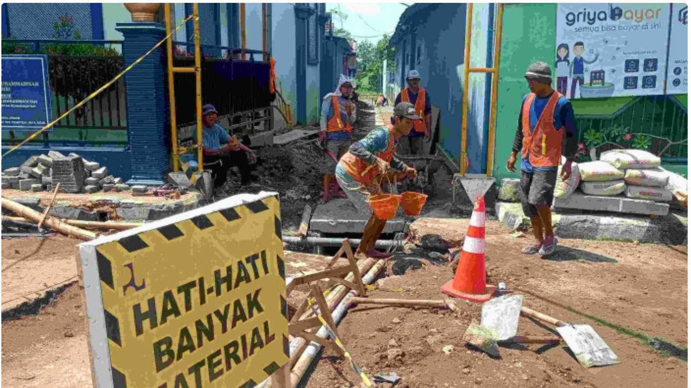
Pekerjaan pembangunan drainase di Banaran terus dikebut. (Foto:prijo atmodjo)
